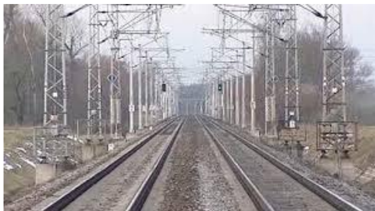
Obr. 19 Moderní trať se zabezpečovacím systémem
